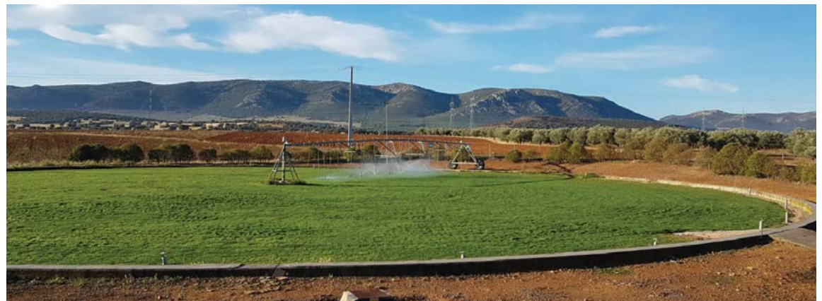
Tratamiento terciario EDAR de Puertollano
